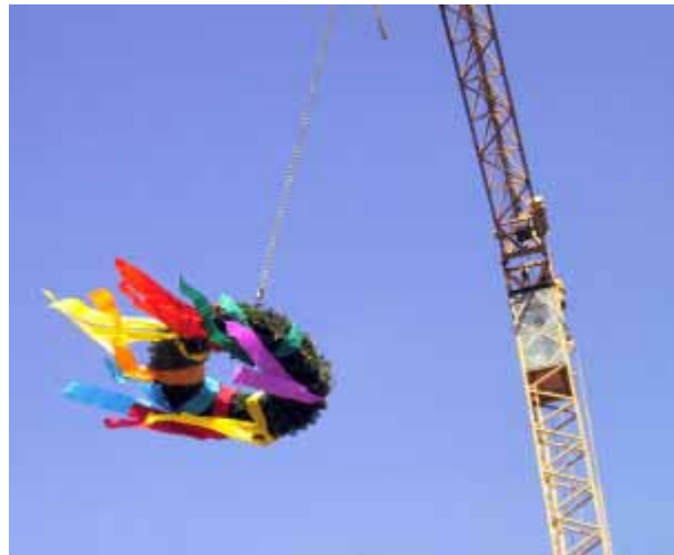
Der Baukran bringt den Richtkranz auf das Stahlfachwerk des INSTAND-Erweiterungsbaus.
